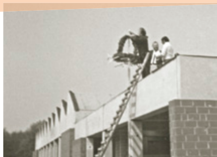
>>>> Richtfest des neuen Werkstattzentrums in Berkhöpen
