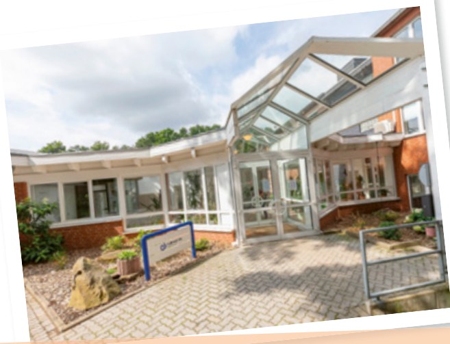
>>>> Februar 2021: Das renovierte Objekt in der Eddesserstr. 1 im Gewerbepark Berkhöpen
