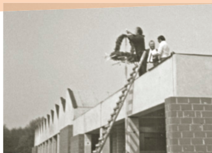
>>>> Richtfest des neuen Werkstattzentrums in Berkhöpen
