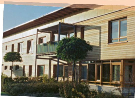
>>>> Wohnstätte Ortbruch in Burgdorf
