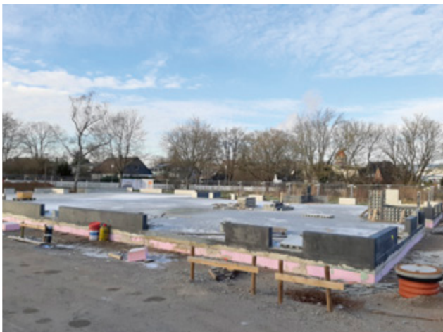
Die wichtigste Grundlage: Ein stabiles Fundament. Die Bodenplatte wird im Dezember 2024 gegossen.
