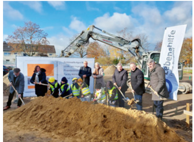
Jetzt kann es losgehen: Neben Vertretern der Stadt Peine, des Landkreises, des Architekturbüros und des Lebenshilfe Vereins setzten die Kinder der Kita Wortschatz im November 2024 feierlich den ersten Spatenstich für ihre neue Einrichtung.
