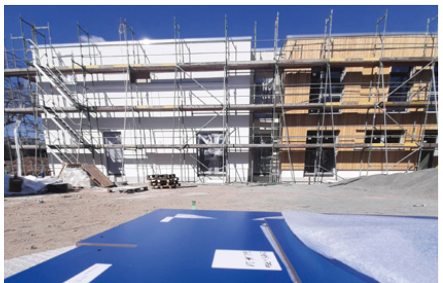
Draußen geht es in der Zwischenzeit auch weiter: Die Fassade aus Lärchenholz und Platten im typischen Lebenshilfe-Blau wird fertiggestellt.
