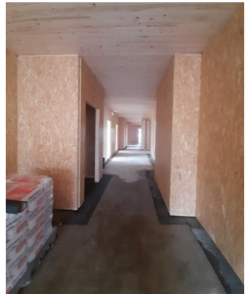
Jetzt kann man innen die Räume einteilen. Überall riecht es nach Holz.
