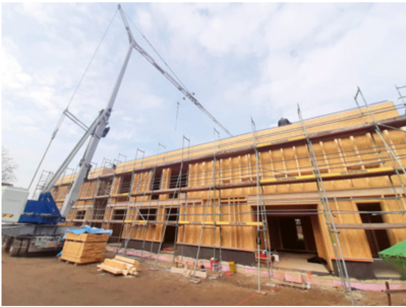
Die Kita Igel bekommt ein Flachdach. Die Dachfläche über der Turnhalle wird begrünt. Das sorgt für Klima- und Hitzeschutz, ist gleichzeitig Wärmedämmung und sieht auch noch gut aus.
