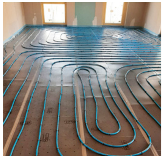
Was aussieht wie ein Labyrinth zum Spielen für die Kinder ist die Fußboden-Heizung. Darauf wird Estrich gegossen.
