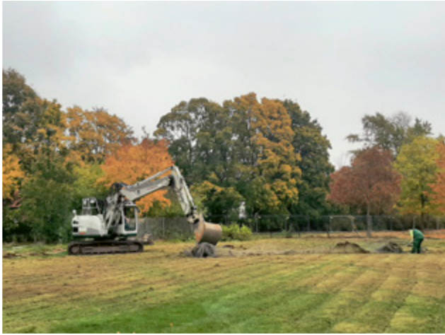
Platz schaffen für die Kita Igel: Ein alter Zaun wird entfernt und wie Sushi zusammengerollt. Die alte Erdschicht wird abgetragen und neue Muttererde angeliefert.
