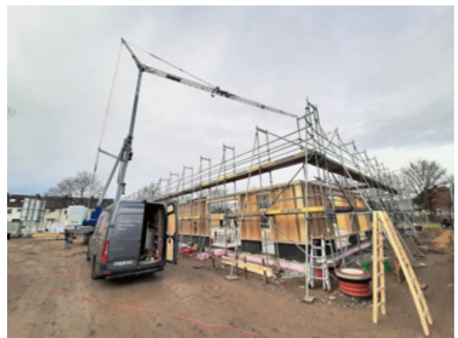
Mit großem Gerät werden die Wände aufgestellt. Durch die Modulbauweise steht das Gebäude besonders schnell. Das Hauptmaterial ist Holz.
