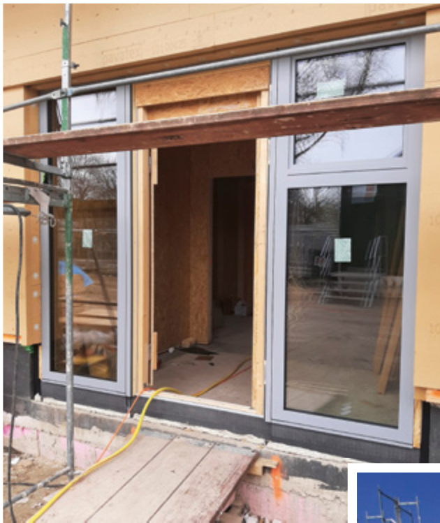
Fenster und Türen braucht eine Kita natürlich auch. Das wird der Haupteingang.
